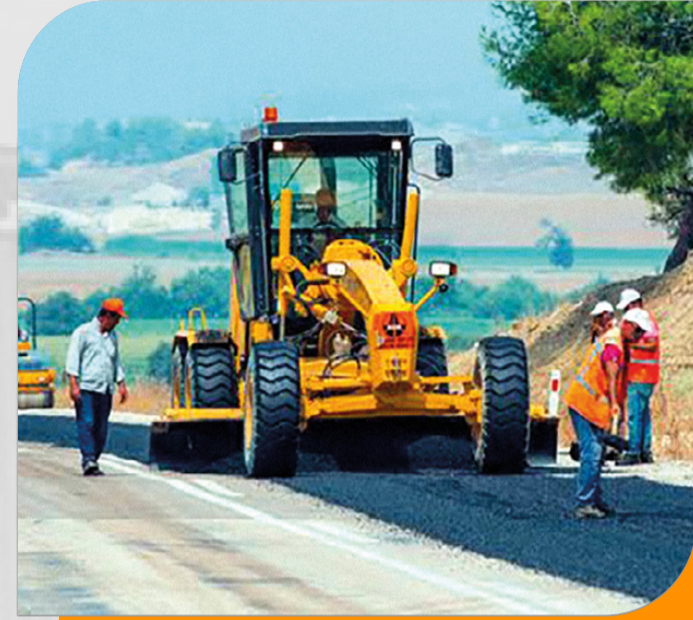
Construcción de carreteras y vías
